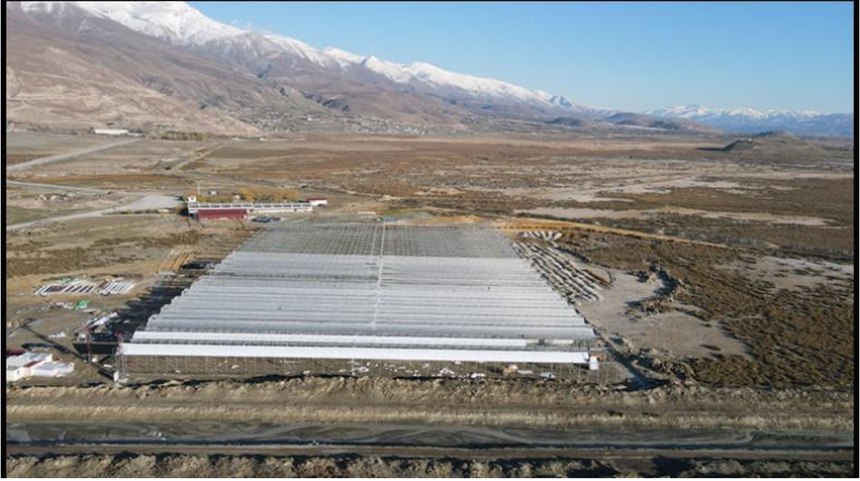
Şekil 30. Erzincan Jeotermal modern sera inşaatı
