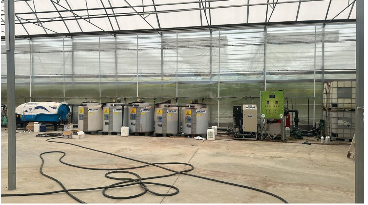
Şekil 37. Jeotermal seranın gübreleme tankları ve ana otomasyon paneli
