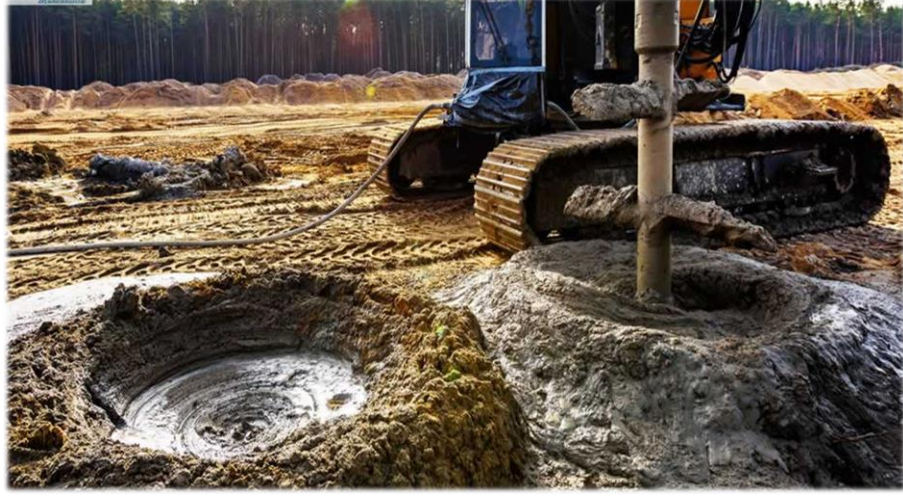
Şekil 2.7: Derin zemin karıştırma ( www.totemzemin.com )
