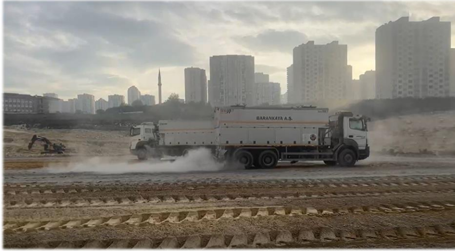
řekil 2.9: Zemine kire eklenmesi (İřstanbul 2025)
