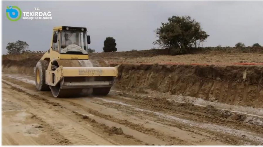
Şekil 2.14: Zeminin titreşimli silindir ile düzeltilmesi (Tekirdağ B.B. 2018)
