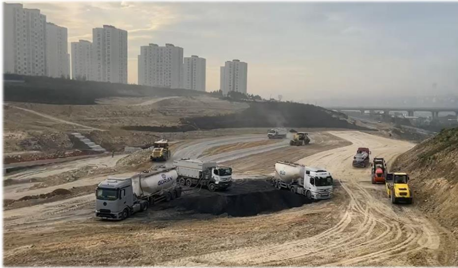
Şekil 2.15: Zemin iyileştirme sahası genel görünüm (İstanbul 2025)
