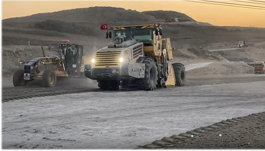
Şekil 2.13: Zeminin karıştırılması ve düzeltilmesi (İstanbul 2025)
