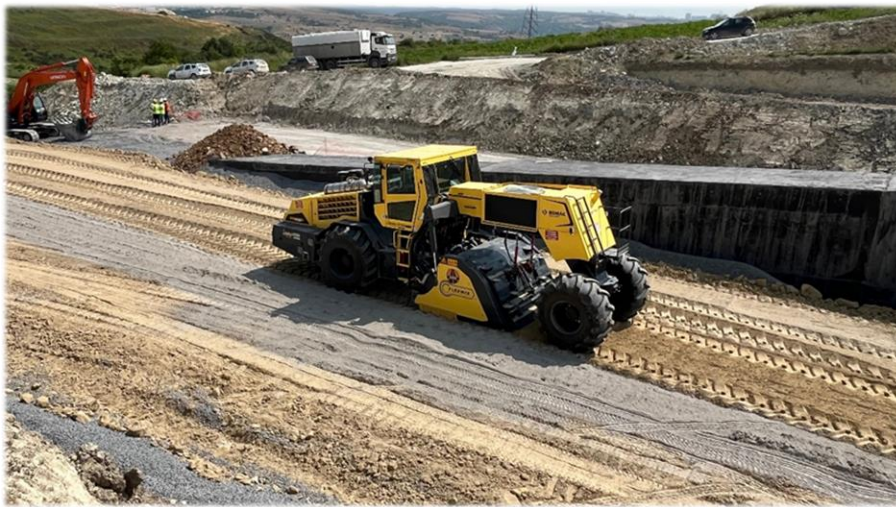
řekil 2.10: Zemin ile kirecin karıřtırılması (İřstanbul 2025)
