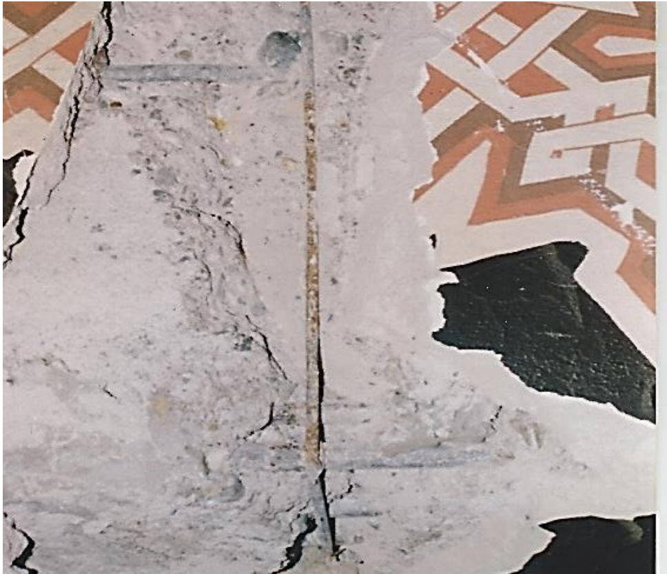
Şekil 2. 2.Donatı sıyrılması (düz donatı).
