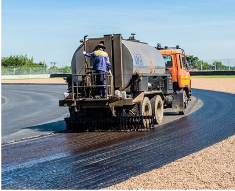
Şekil 2.8. Bitüm ile zemin stabilizasyonu (Tipco Asphalt, 2024)
