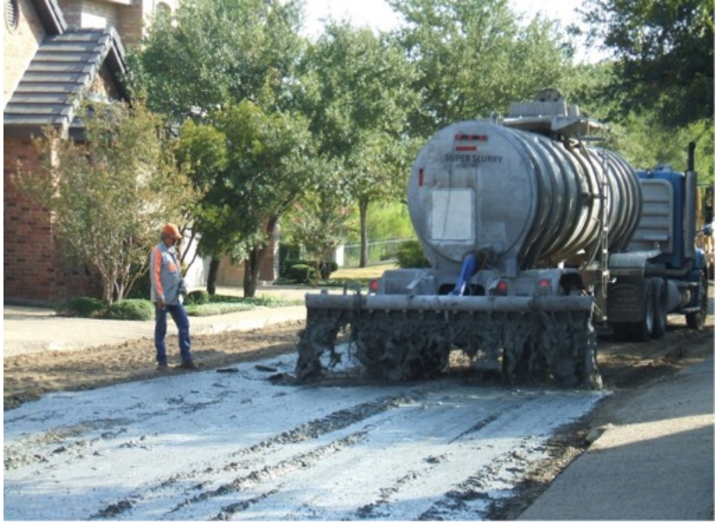
Şekil 2.7. Çimento ile zemin stabilizasyonu (Cement Treated Material, 2024)
