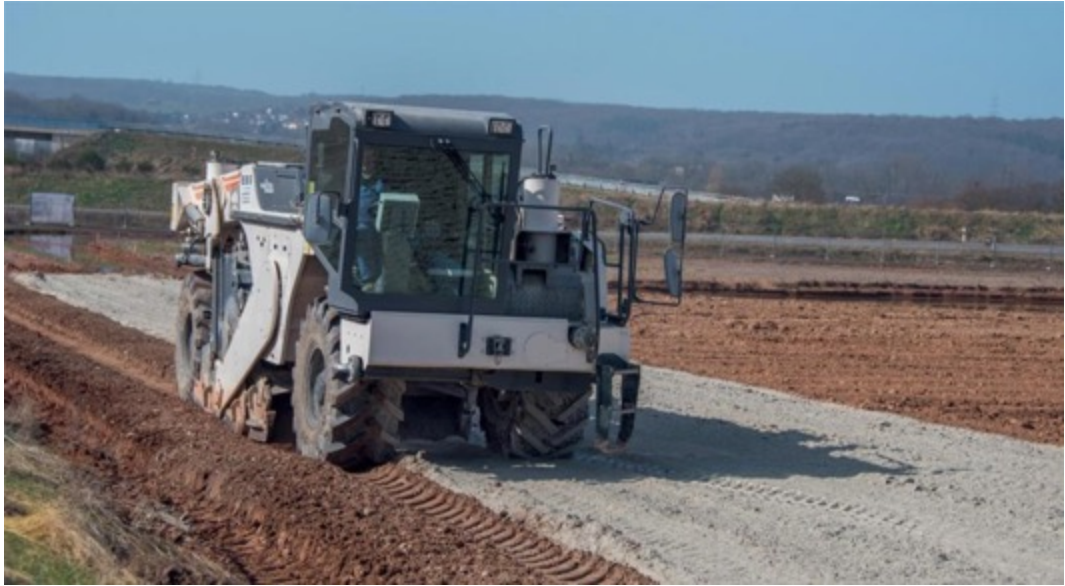
Şekil 2.9. Uçucu külün ile zemin stabilizasyonu (Baxmeyer Construction, 2024)
