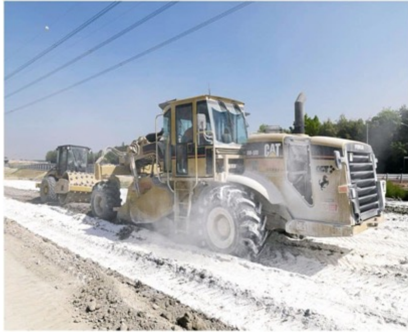
Şekil 2.6. Kireç zemin stabilizasyonunun sahada uygulanması (Engineering Civil, 2024)
