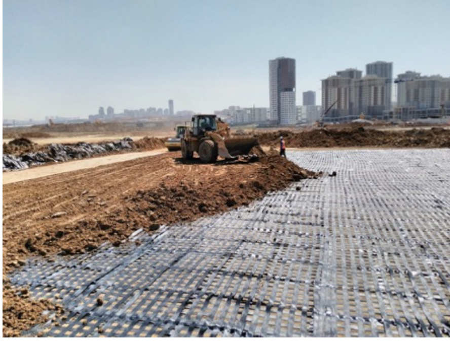
Şekil 2.11. Geosentetikler ile Zemin İyileştirme (Maccaferri, 2024)
